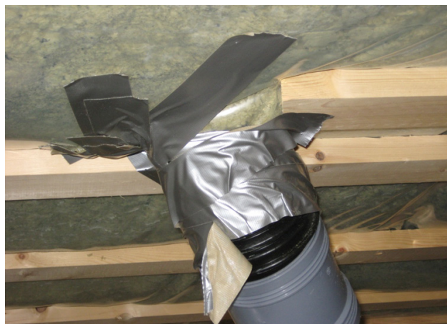
Genomföringar tätade med silvertejp.
