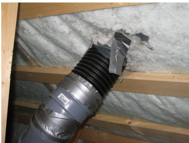
Tätningar kring genomföringar med silvertejp.
