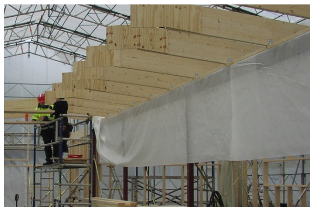
Fig 12 Exempel på plastfolie som i tidigt skede applicerats mellan konstruktionsdelar.
