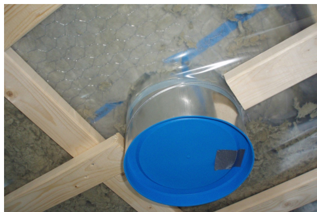
Fig 13 Håltagning för en vägggenomföring. Ett större hål har först tagits genom inre skivbeklädnad vilket sedan möjliggör åtkomlighet att tätta mellan plastfolien och det rör som ska genomföras.
