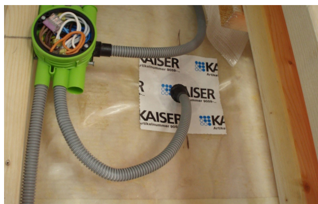
Fig 14 & 15 Ett par exempel på goda lösningar för tätning av genomföringar i plastfolie. Manschett för elgenomföring respektive anpassad håltagning för ventilationskanal där håltagning i plastfolien gjorts något mindre än kanalen som sedan trängts igenom.
