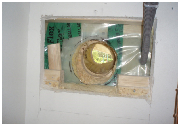
Fig 13 Håltagning för en vägggenomföring. Ett större hål har först tagits genom inre skivbeklädnad vilket sedan möjliggör åtkomlighet att tätta mellan plastfolien och det rör som ska genomföras.
